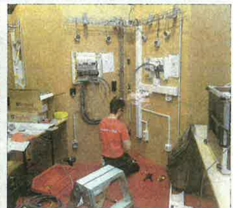
Marco Freches arbeitete an einer Installationswand.
