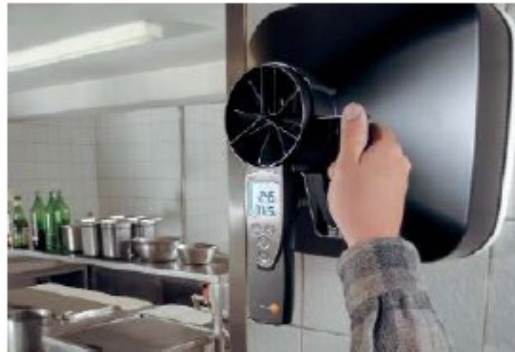
Kontrolle der Abluft am Aufputzlüfter
